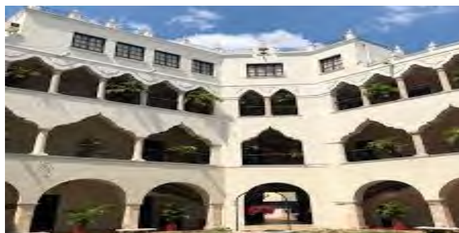
Edificio central de la Uady, que también ocupó la Facultad de psicología.
